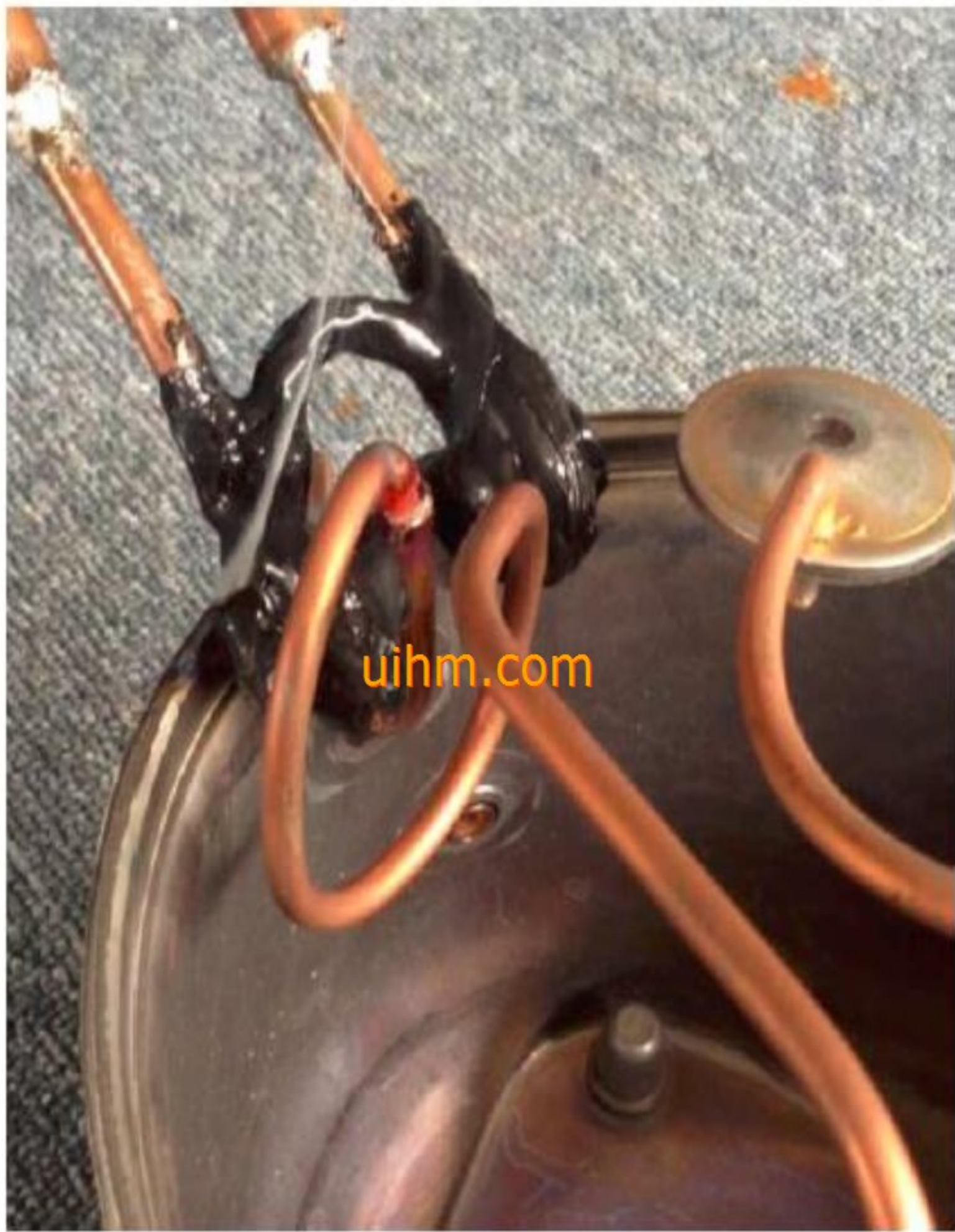
冰箱管路焊接
